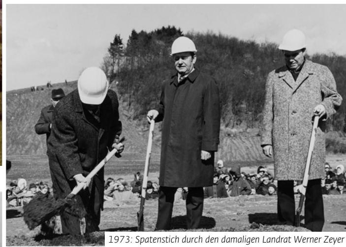
1973: Spatenstich durch den damaligen Landrat Werner Zeyer
